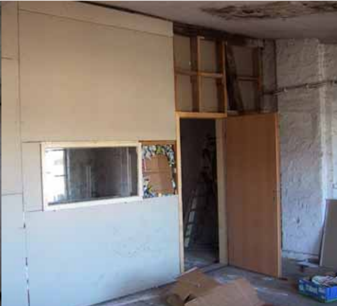
Radio_C Studio Rohbau
